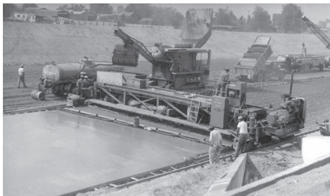
Каналокладчик G&Z на рельсовом ходу, укладывающий дно канала в Лос-Анджелесе, Калифорния, США (1957). ▲ ◀ Трапецевидный траншеекопатель G&Z в Перу (1957).
