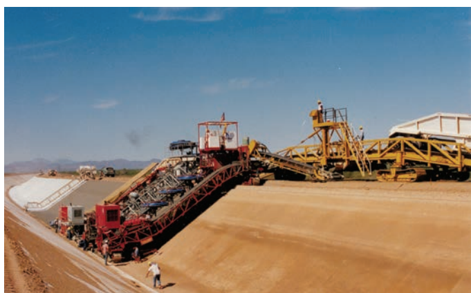
▲ Разгрузка полуприцепа в гусеничный перегружатель
