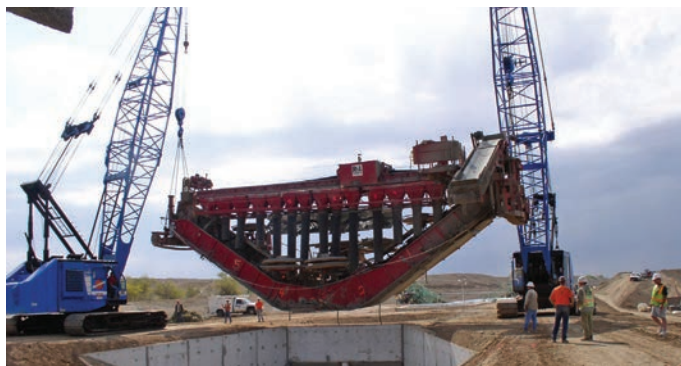
Два больших крана перемещают полнопрофильный каналокладчик над сооружением по трассе канала
