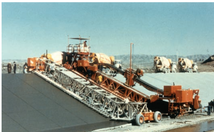
▲ Разгрузка двух миксеров на скребковый конвейер
