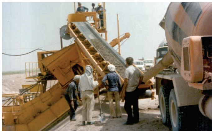
▲ Разгрузка миксера в распределительный скип
