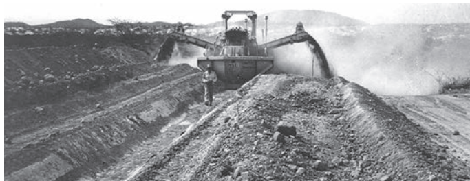
Каналокладчик G&Z на рельсовом ходу, укладывающий дно канала в Лос-Анджелесе, Калифорния, США (1957). ▲ ◀ Трапецевидный траншеекопатель G&Z в Перу (1957).
