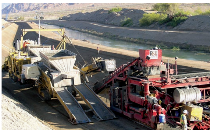
▲ Тандемные полуприцепы разгружаются в гусеничный перегружатель
