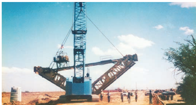
Полнопрофильный триммер перемещается гусеничным 250 тонным краном вокруг сооружения.
