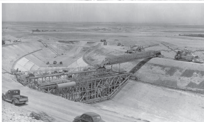
Триммер на рельсовом ходу G&Z (вверху страницы) и каналокладчик (вверху) (1947), работающие на строительстве канала Дельта Мэндотаб Калифорния, США. ▲
