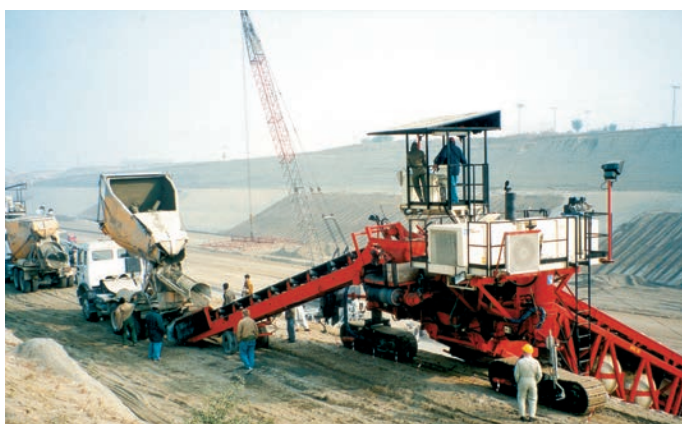
▲ Разгрузка миксера в распределительный скип
