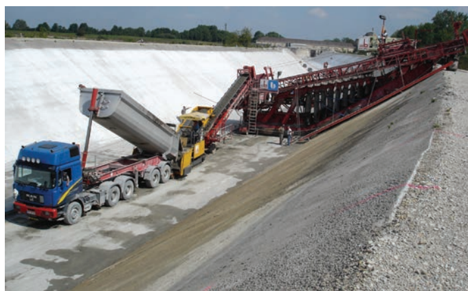
▲ Полуприцеп-самосвал, разгружающийся в бетоноукладчик
